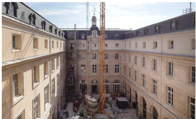
Cour d'honneur en chantier.
