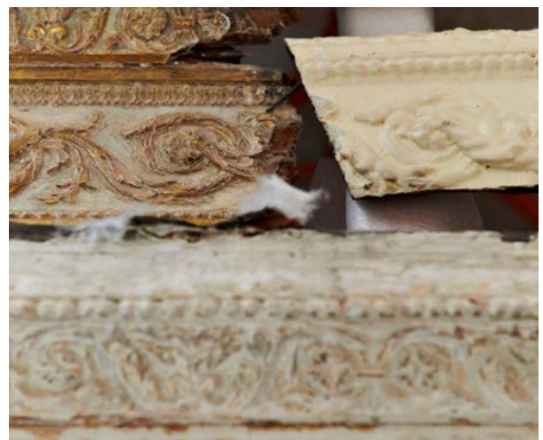
Restauration des décors peints : corniches déposées.
