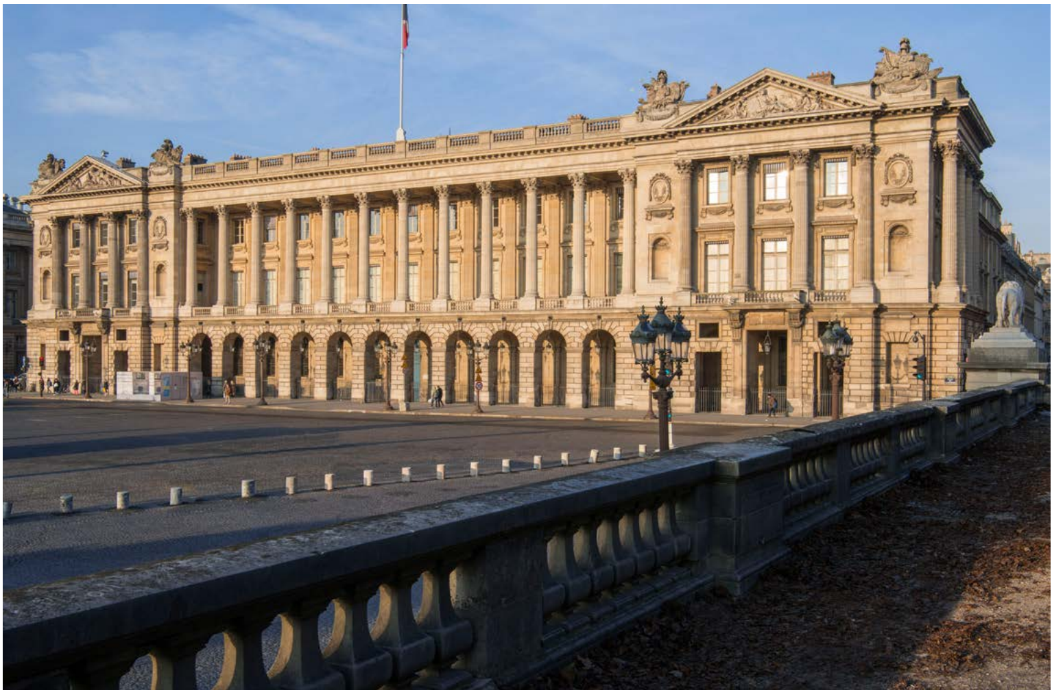
La façade sur la place de la Concorde.
